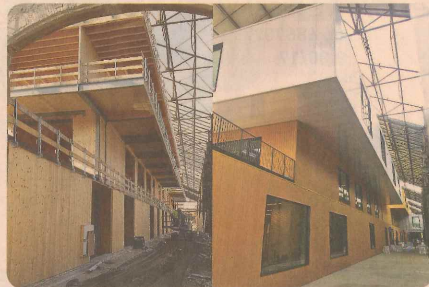
Cantiere e fine lavori - Parco Innovazione ex Officine Reggiane - Reggio Emilia
