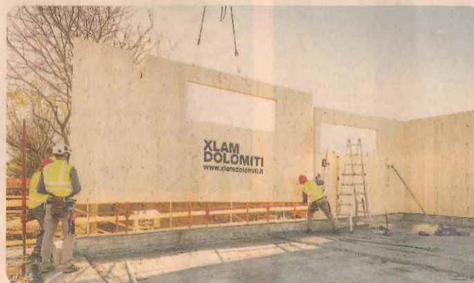
Palazzina commerciale - cantiere Lazise - Verona
